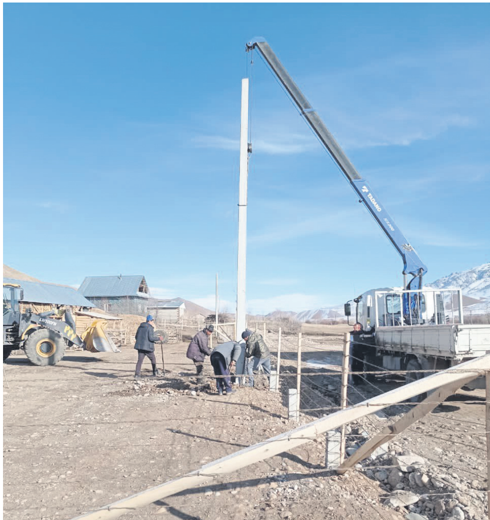
Айылдардагы жаңы түшкөн көчөлөргө бетондон электр түркүктөрү коюлууда.
