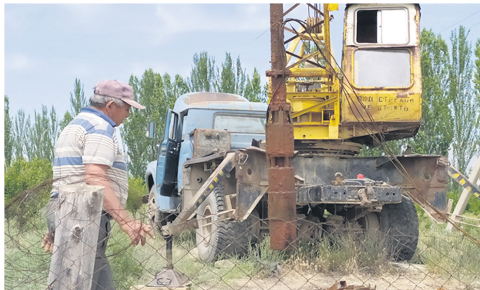
Бакай-Ата айыл өкмөтүнө караштуу УОС жана Парник скважиналарынын насостору алмашылып орнотулду
